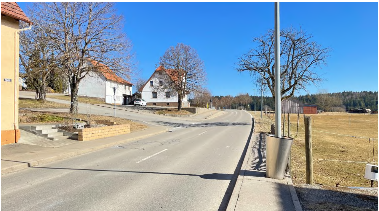
Ansicht Hauptstraße mit Baugebiet rechts
